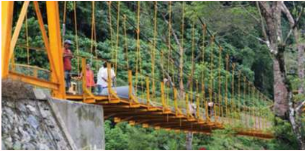
Gambar 1.4 Pembangunan jembatan gantung di daerah terpencil mencerminkan perwujudan keadilan sosial
